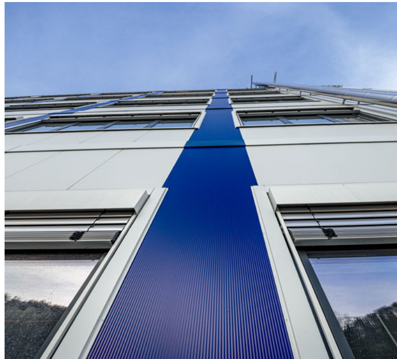
Das Gebäude K in Bubendorf ist Bachems grösstes Ausbauprojekt und soll die Kapazität in Bubendorf im Endausbau verdoppeln.
